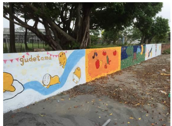
故事牆打底完成
